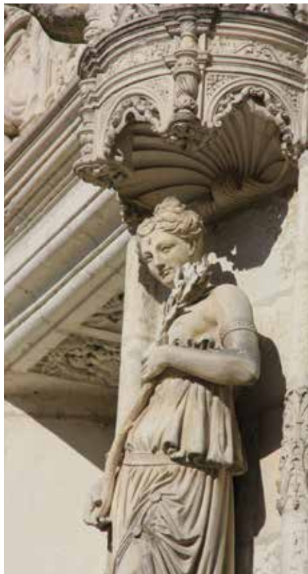
Château Royal de Blois - Détail de l'escalier François Ier - © D. Lepissier
